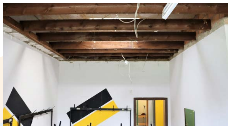
In den Kabinen des FC Lauingen zeigt sich, was das Hochwasser angerichtet hat. Die Decken sogten sich voll und brachen herunter. Bild: Jonathan Mayer
